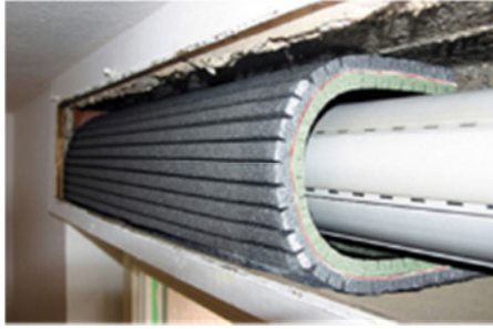
Abbildung 24: Rollladenkastendämmung 19
